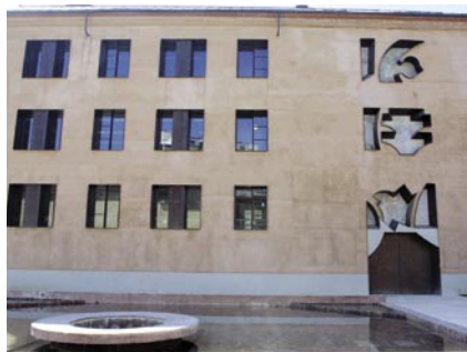
27.- Biblioteca María Moliner Ventanas y puerta fachada en patio interior
