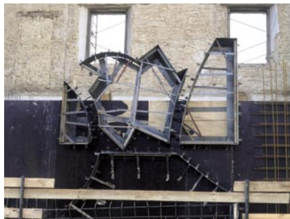
29.- Biblioteca María Moliner Preparación del encofrado Primera ventana y puerta
