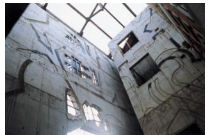
12.- Biblioteca María Moliner Proceso de desencofrado de los muros
