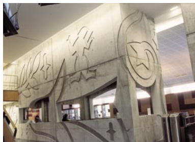
36.- Centro de Historia Relieves y mostradores en muro de hormigón, planta baja
