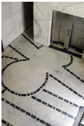
14.- Biblioteca María Moliner Suelo planta baja con teselas en piedra de Calatorao Piezas de 10 x 10 cm y 10 x 20 cm Dimensiones totales suelo: 10,7 x 5,94 m
